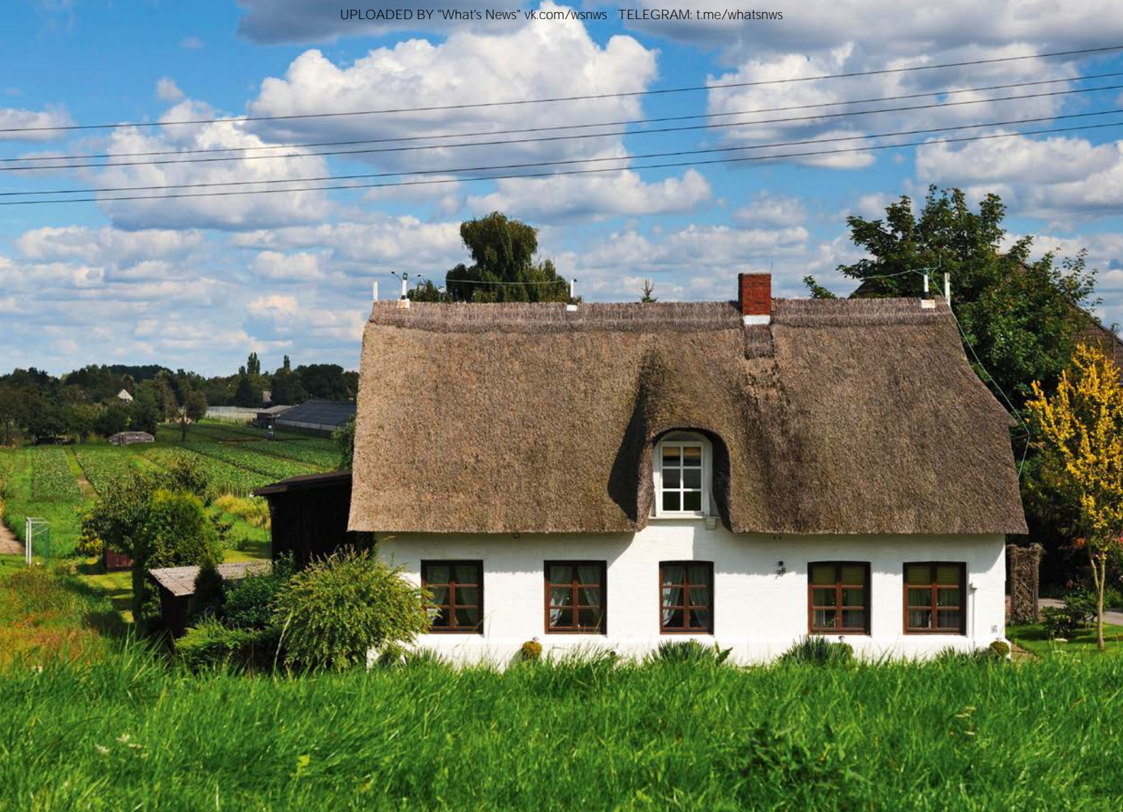
Im Spadenland sind sie noch zu sehen: Häuser mit traditionellem Reetdach, wie sie früher für ganz Norddeutschland typisch waren.
