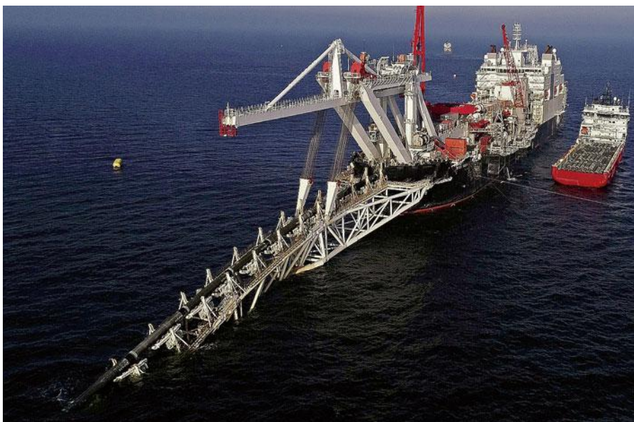
Pipelineverlegeschiff in der Ostsee 2018: Längeren Baustopp einkalkuliert
