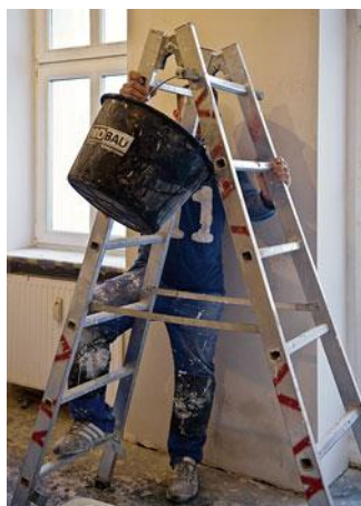
Arbeiter auf Baustelle
